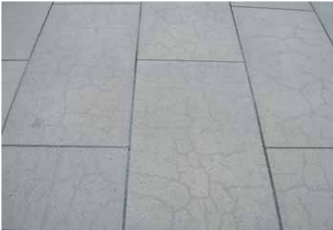
Vor der Oberflächensanierung
