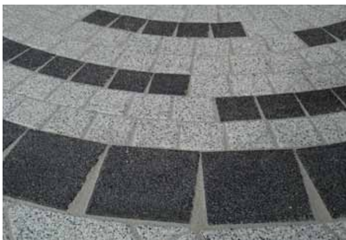
Nach der Verfugung
