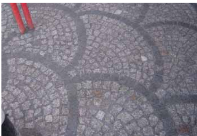
Nach der Pflasterfugensanierung
