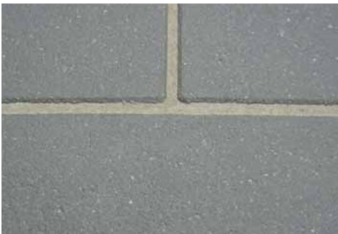
Nach der Oberflächensanierung
