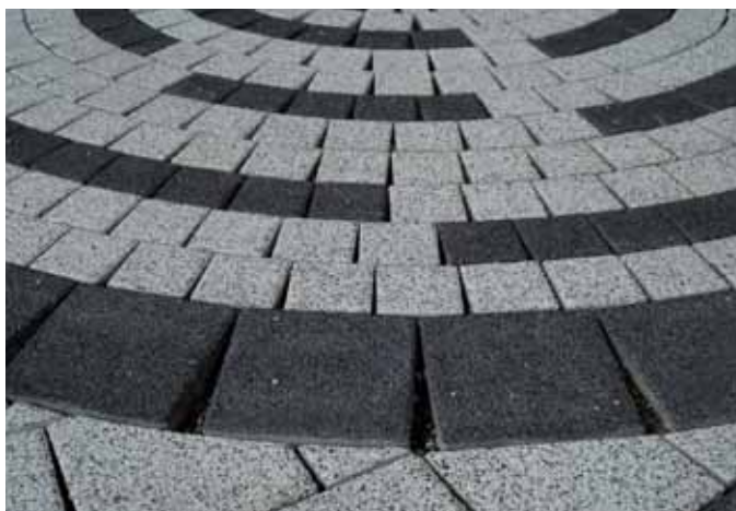
Vor der Verfugung
