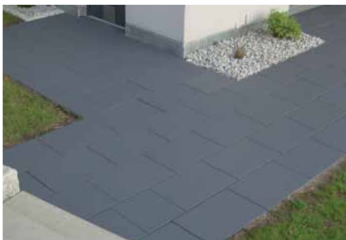
Nach der Oberflächensanierung
