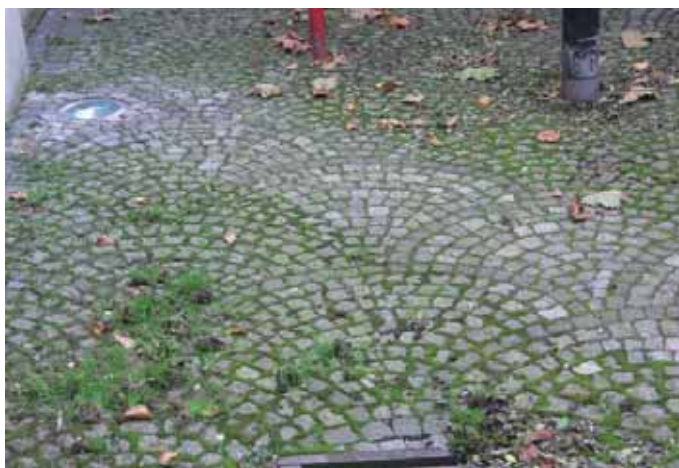
Vor der Pflasterfugensanierung
