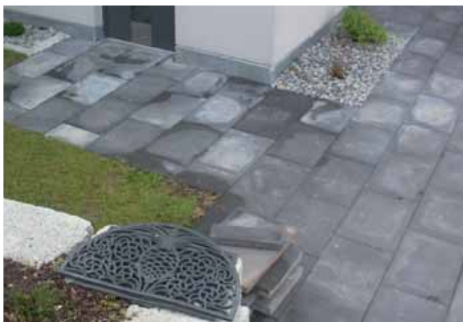
Vor der Oberflächensanierung
