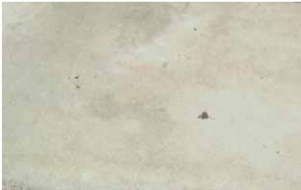
Betonoberflächen sanden ab, in Wasser gelöste Stoffe dringen in das Betongefüge ein. Irreparable Verschmutzungen sowie Tausalzschäden sind die Folgen.
