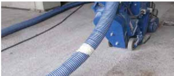
Vollflächig werden die Bodenbeläge kugelgestrahlt oder abgeschliffen.
