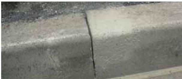
Als erstes wird der Betonbordstein mit einem entsprechenden Reinigungsverfahren gereinigt. Lose Teile und Verschmutzungen entfernt.
