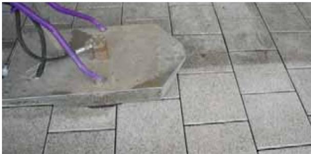
Die Verschmutzungen werden durch unseren SanTec CleanScater ohne Einsatz von chemischen Reinigungsmitteln an der Oberfläche abgelöst und über die integrierte Schmutzwasserabsaugung umweltfreundlich von der Fläche abgeleitet.
