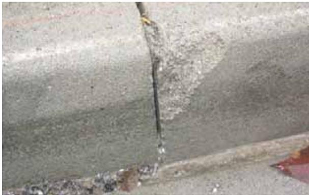
Schadhafte, mehr oder weniger zerstörte Bordsteine aus Beton sind verkehrsgefährdend, optisch unbefriedigend und führen unter Umständen zu schweren Folgeschäden an Gehwegen und Straßen.
