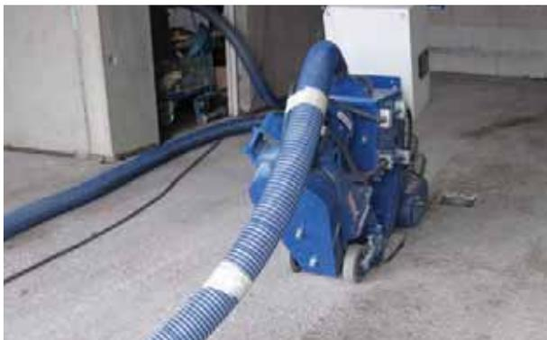
Durch dieses Verfahren werden Schlemperschichten, Schadstellen, Rost sowie hartnäckige Verschmutzungen sicher von der Oberfläche beseitigt.
