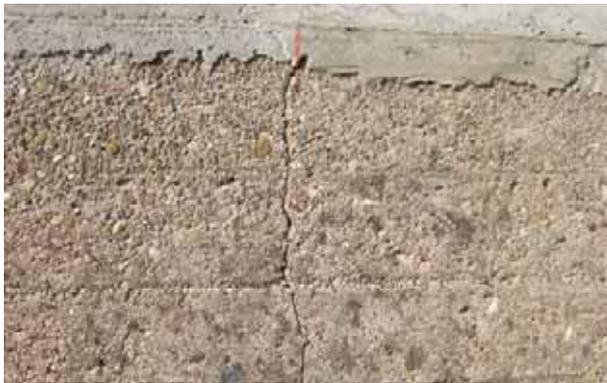
Wasser kommt auf vielfältige Weise in ein Bauwerk. Zum Beispiel durch Risse, poröses Mauerwerk oder durch aufsteigende Feuchtigkeit in Kiesnestern.
