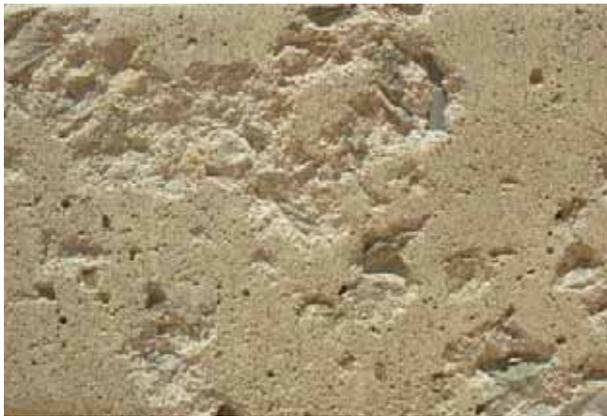
Durch mechanische Einflüsse oder Witterungsschäden können Mauerstützwinkel beschädigt werden.
