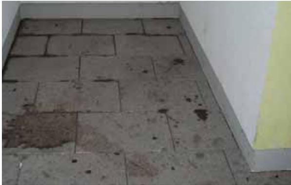
Im Laufe der Zeit verschmutzen Pflaster- und Plattenbelag durch Moose, Staub, Reifenabrieb und andere Umwelteinflüsse.
