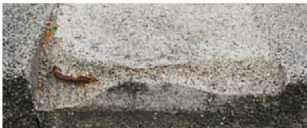
Die beschädigten Stellen werden gereinigt, lose Teile entfernt. Eisenbewehrungen überarbeitet und im Bedarfsfall der noch vorhandene Beton durch Tränkung oder Injektion stabilisiert.
