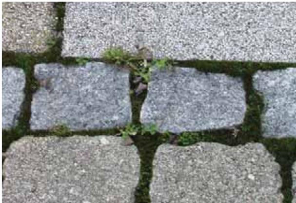
Viele Gehwege, Straßen und Plätze werden in offener Bauweise verlegt und mit Sand oder Splitt verfügt. Verkrautung, Auswaschungen und der Einsatz von Kehrmaschinen führen mit der Zeit zu leeren Fugen.
