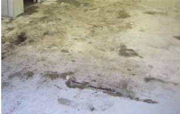
Betonböden insbesondere Industrieböden werden aufgrund ihrer erhöhten Beanspruchung rau und sanden ab.
