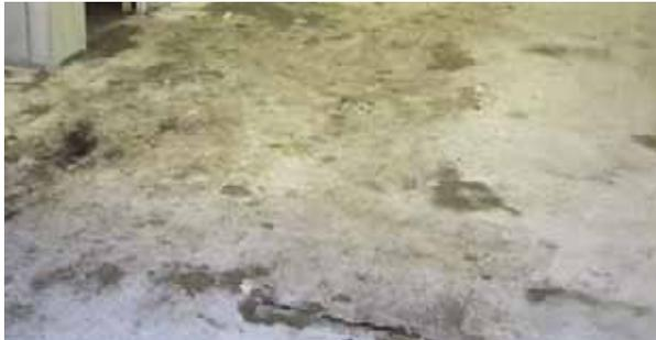
Wo mit aufsteigender Feuchtigkeit zu rechnen ist, wie z. B. bei erdberührten Flächen, sind wasserdampfdiffusionsfähigen Bodenbeschichtungen die ökonomische, ökologische und sichere Lösung.
