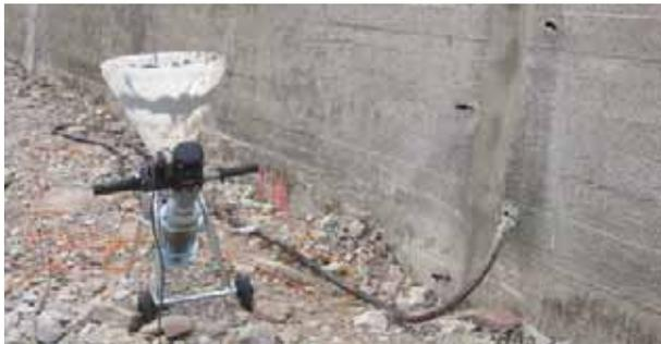
Die Risse werden mit einer Spachtelmasse verspachtelt, damit der Expansionsmörtel nicht austreten kann.
