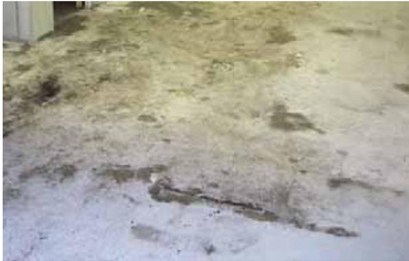
Betonböden sanden ab, Verschmutzungen dringen tief in den Beton ein. Öl- Fett und andere Substanzen lassen sich aus der Betonoberfläche nicht mehr entfernen.
