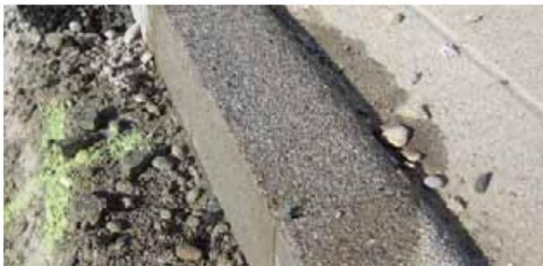
Als erstes wird der Betonbordstein mit einem entsprechenden Reinigungsverfahren gereinigt. Lose Teile und Verschmutzungen werden entfernt.
