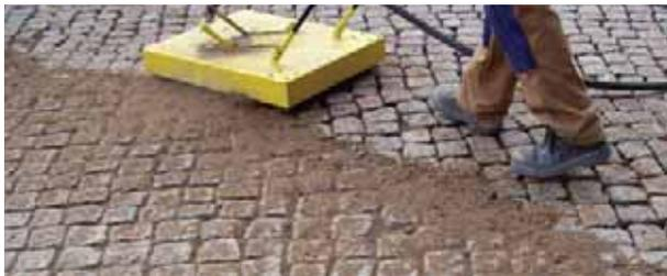
Die losen Fugen werden mit einem Spezialgerät auf die nötige Tiefe ausgeräumt. Dabei wird die Fugenfüllung herausgelöst. Das ausgeworfene Material kann mit einem Besen oder einer Kehrmaschine beseitigt werden.
